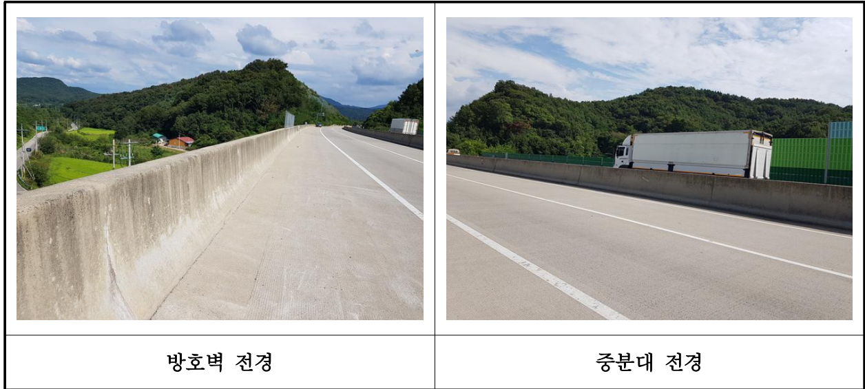
【사진 3.3.24】 방호벽 및 중앙분리대 전경
