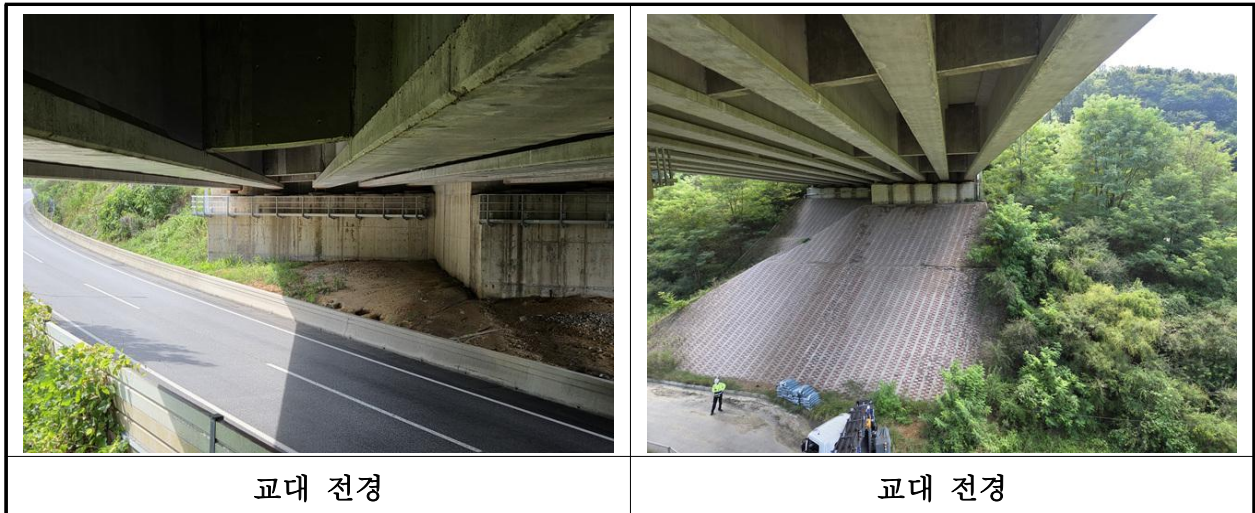
【사진 3.3.35】 교대 전경
