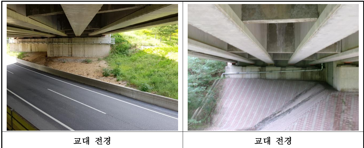
【사진 3.3.8】 교대 전경
