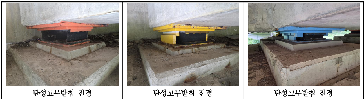
【사진 3.3.40】 교량받침 전경
