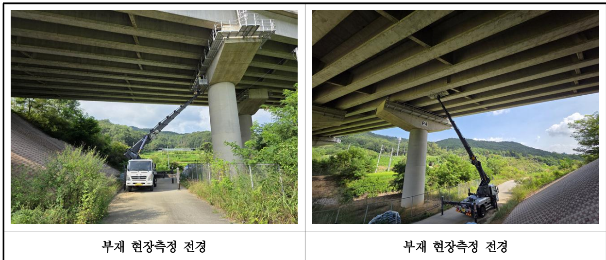
【사진 3.2.1】 부재 현장측정 전경
