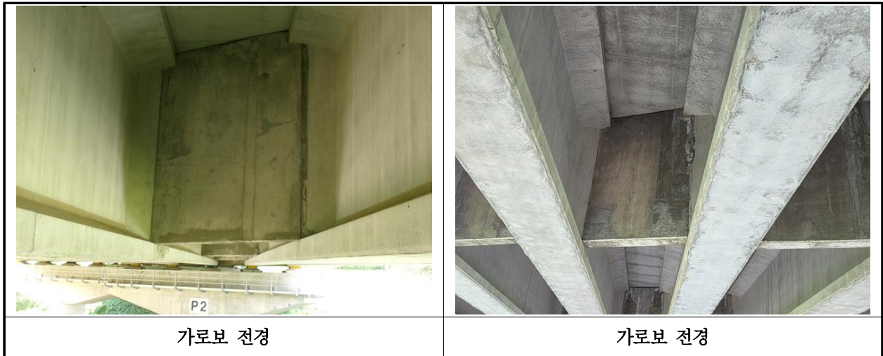
【사진 3.3.6】 가로보 전경
