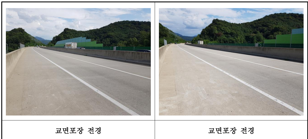
【사진 3.3.20】 교면포장 전경
