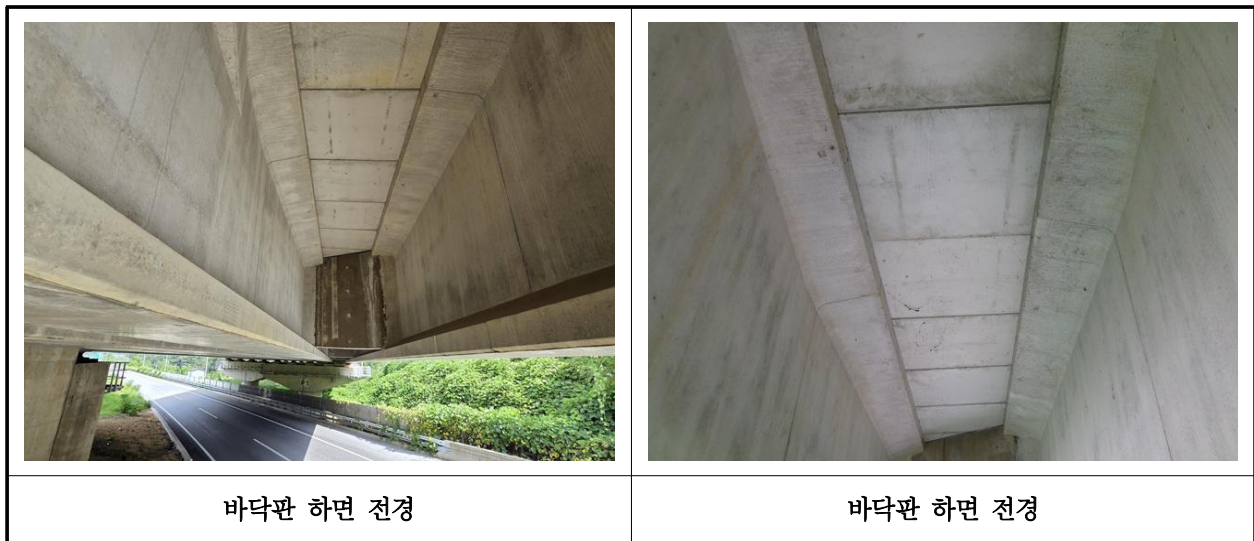
【사진 3.3.29】 바닥판하면 전경
