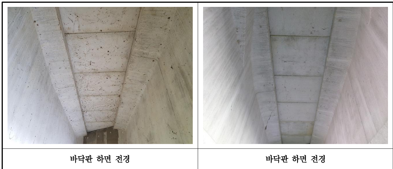
【사진 3.3.2】 바닥판하면 전경
