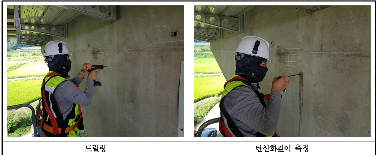
【사진 3.4.3】 탄산화 깊이 측정 현장사진
