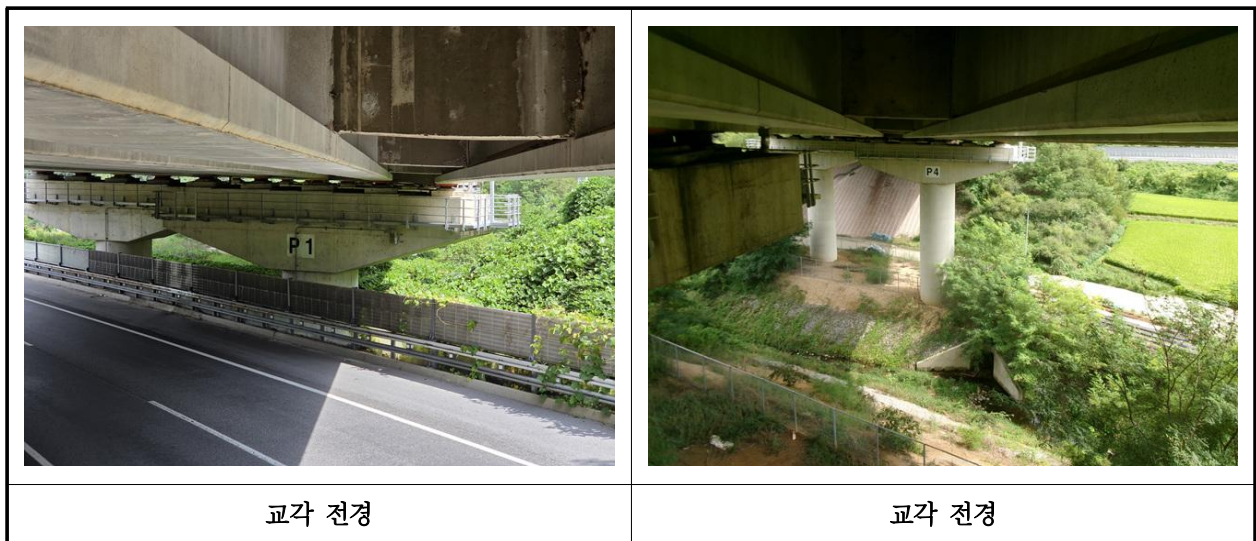
【사진 3.3.37】 교각 전경
