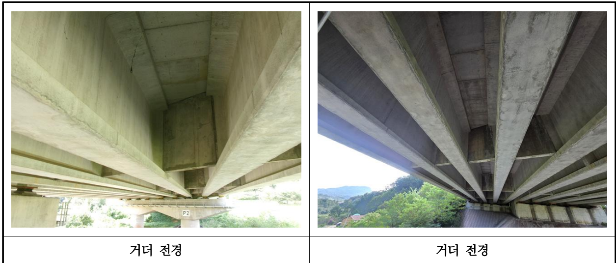
【사진 3.3.4】 거더 전경
