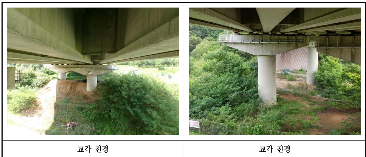
【사진 3.3.10】 교각 전경
