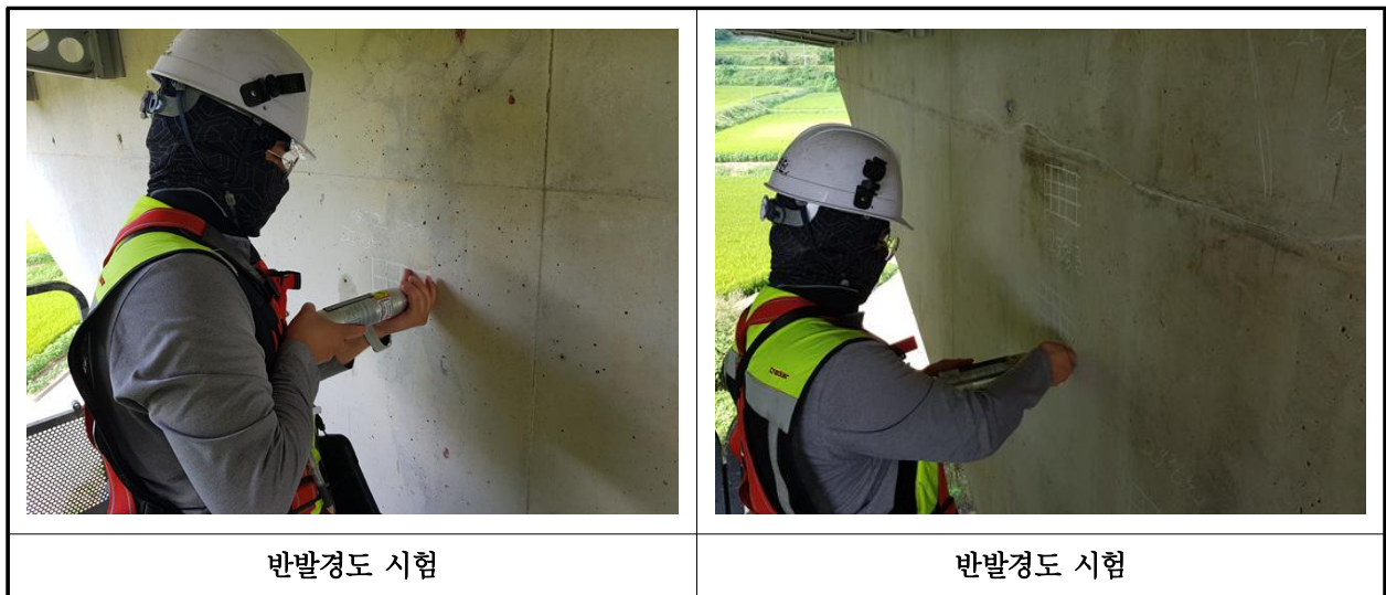
【사진 3.4.2】 반발경도시험 현장사진
