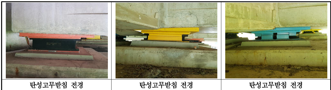
【사진 3.3.13】 교량받침 전경
