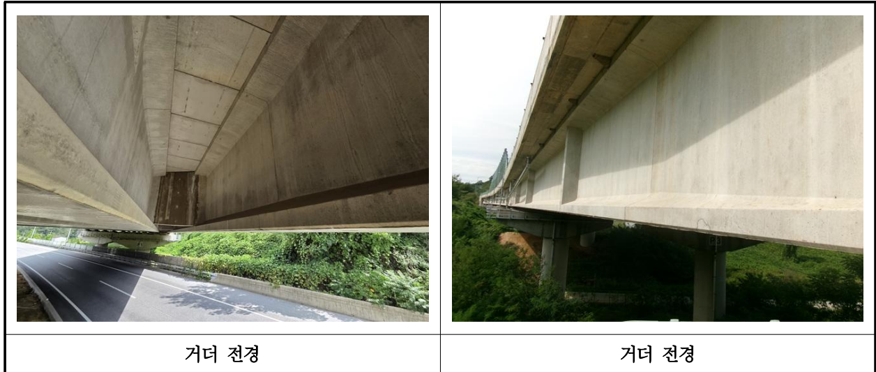
【사진 3.3.31】 거더 전경
