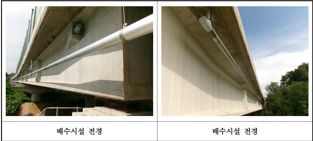
【사진 3.3.49】 배수시설 전경
