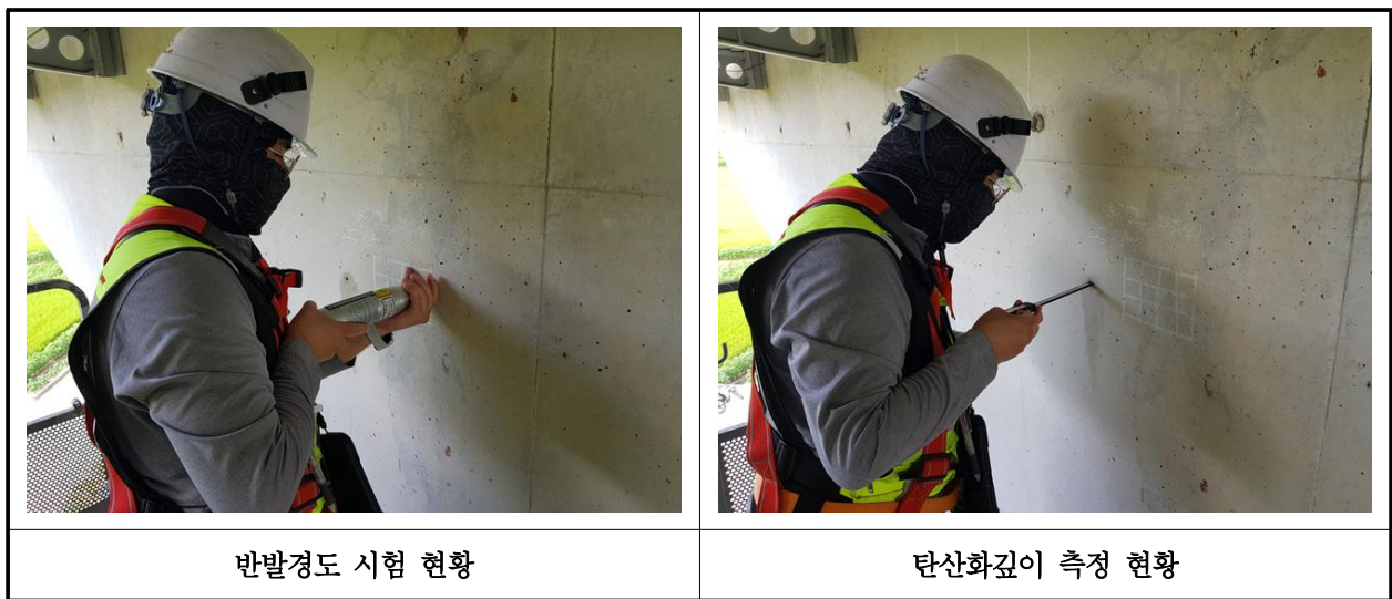
【사진 3.4.1】 콘크리트 내구성조사 현황
